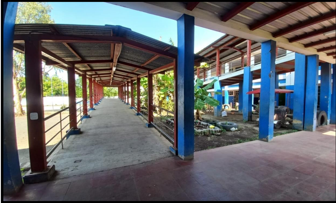
Rampla que conduce al segundo piso
