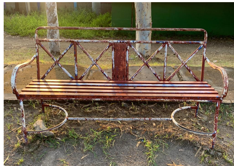
Nota 27 Las bancas metálicas muestran la falta de mantenimiento. Adaptado de (Fuente: Elaboración propia)
