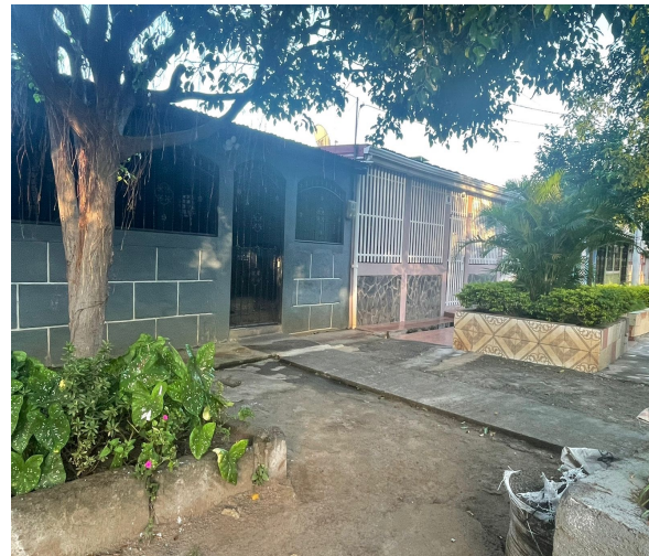
Imagen #21: Vivienda colindante este
