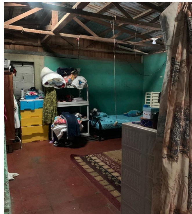
Imagen #26: Grietas y deformaciones en las paredes, escasez de particiones internas y distribución de los espacios, estructura de techo deteriorada, expuesta y oxidada.
