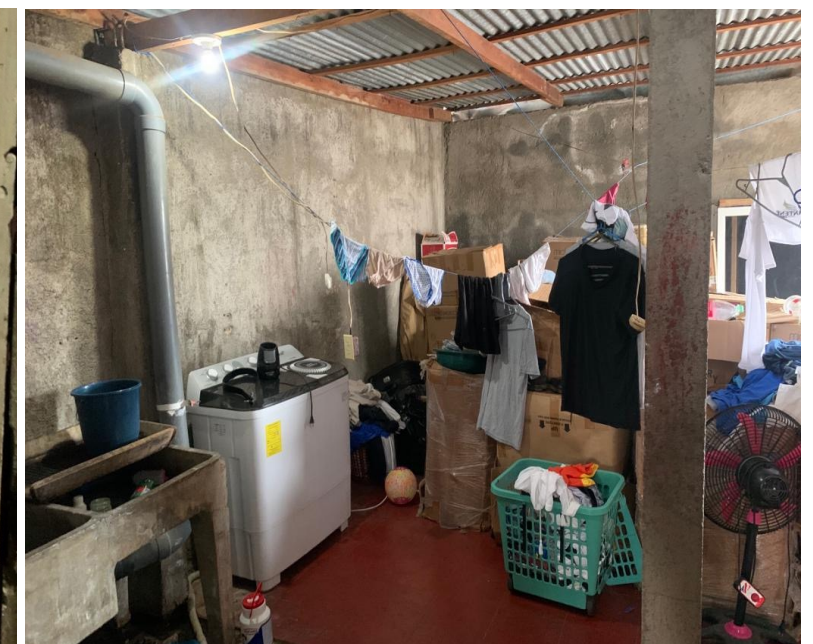
Imagen #29: Mala instalación de tuberías, expuestas lo cual produce humedad en las paredes, en el área de servicio sanitario y de lavado
