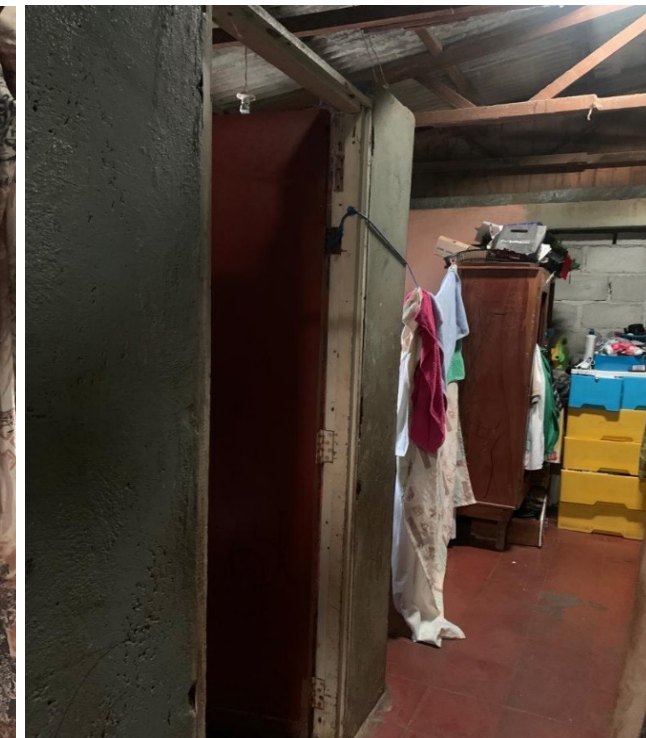
Imagen #26: Grietas y deformaciones en las paredes, escasez de particiones internas y distribución de los espacios, estructura de techo deteriorada, expuesta y oxidada.
