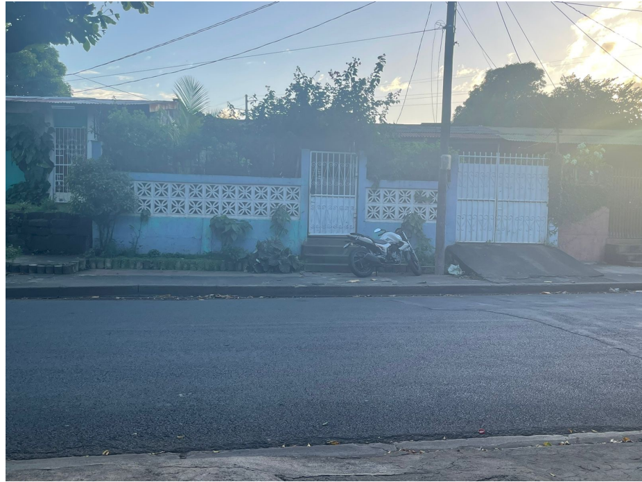
Imagen #19: Vista de vivienda frontal sur
