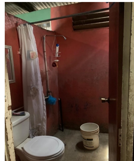
Imagen #29: Mala instalación de tuberías, expuestas lo cual produce humedad en las paredes, en el área de servicio sanitario y de lavado
